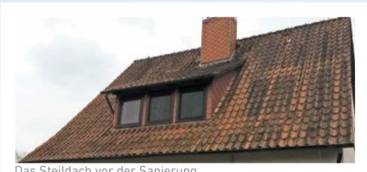
Das Steildach vor der Sanierung.
