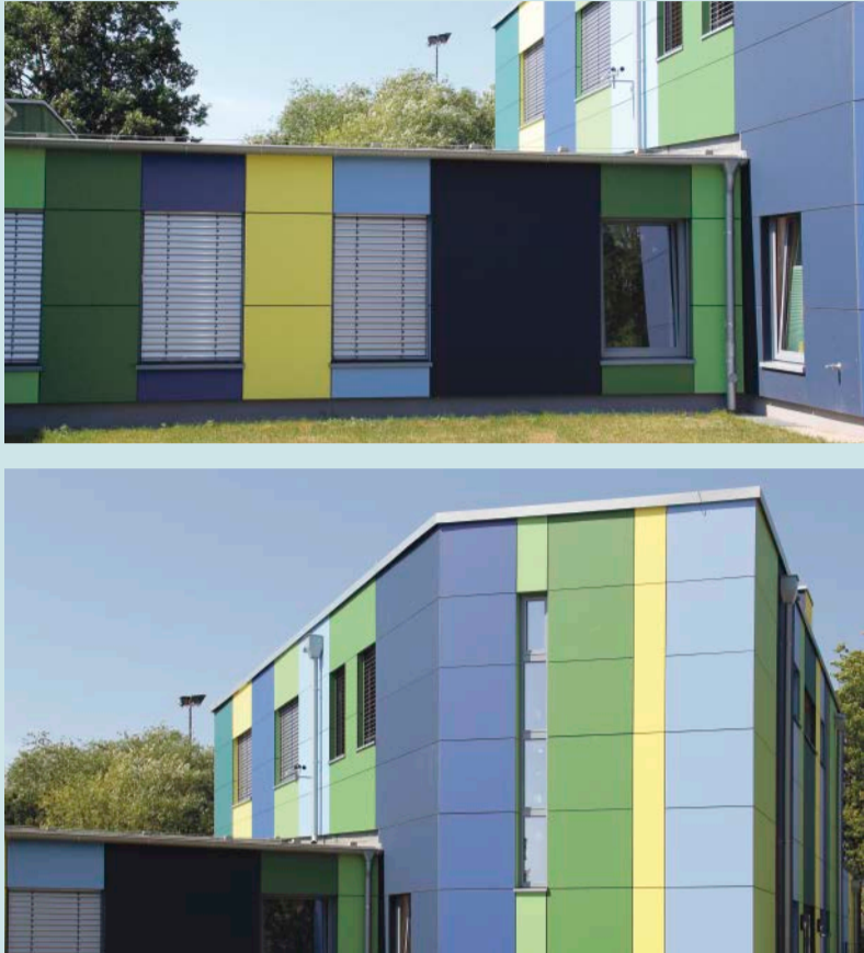
Die Fassade aus Eternit Equitone pictura 8 mm bietet eine gute Dämmung und eine einladende Optik.
