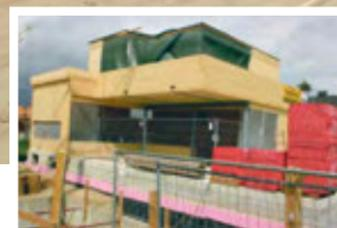
Insbesondere für vor- und rück-springende Geschosse sind die flächigen Elemente ideal geeignet. Dabei erfüllen die Bauteile alle Anforderungen an Statik und Aussteifung, Brandschutz und Bauphysik.
